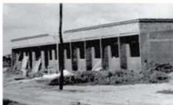
Prédio da Santa Casa em construção.
