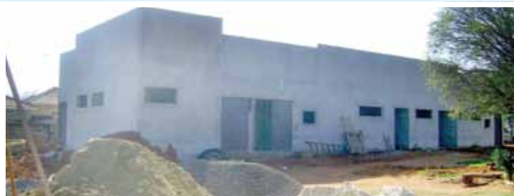
Obras da Fase A-1
